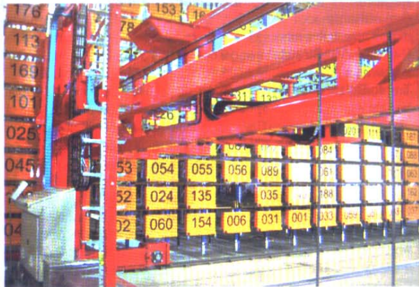
Un'immagine del magazzino automatico per profili installato presso la nuova sede di Espace Aluminium a Bordeaux, in Francia
